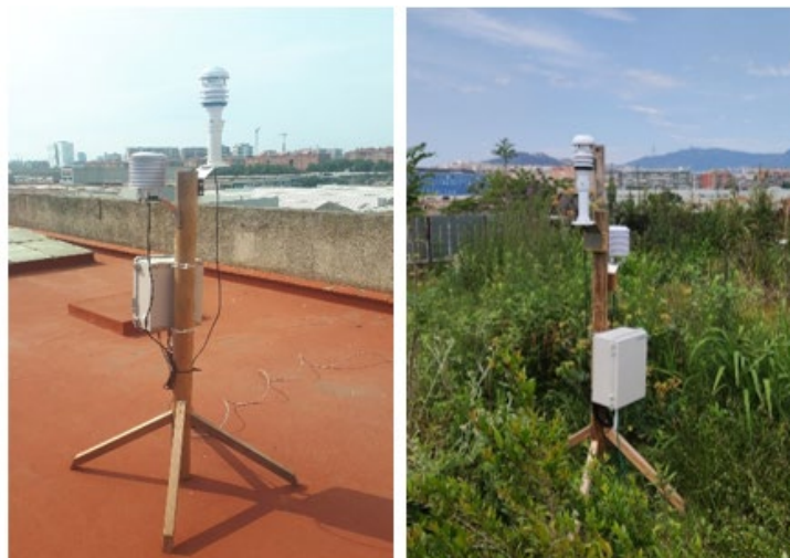
Figura 10. Equipament instal·lat a dues cobertes veïnes, una convencional acabada amb rajola ceràmica i l'altra verda semi-intensiva biodiversa.
